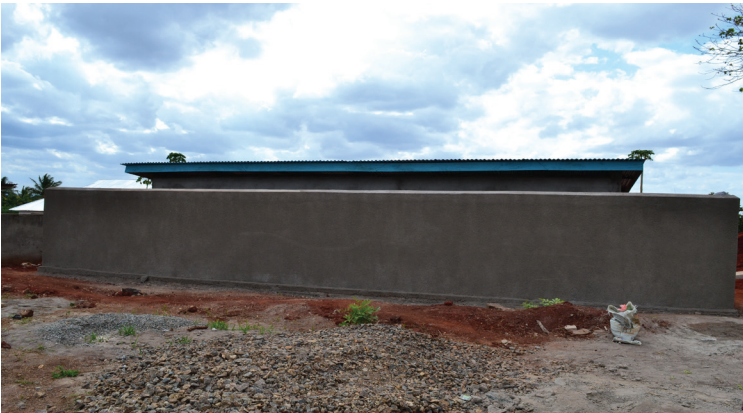
Ujenzi wa vyoo bora vya wanafunzi wa shule ya Sekondari Segera ukiwa katika hatua za mwisho za ukamilishaji, katika kuhakikisha Usafi wa vyoo kuepuka maradhi.
