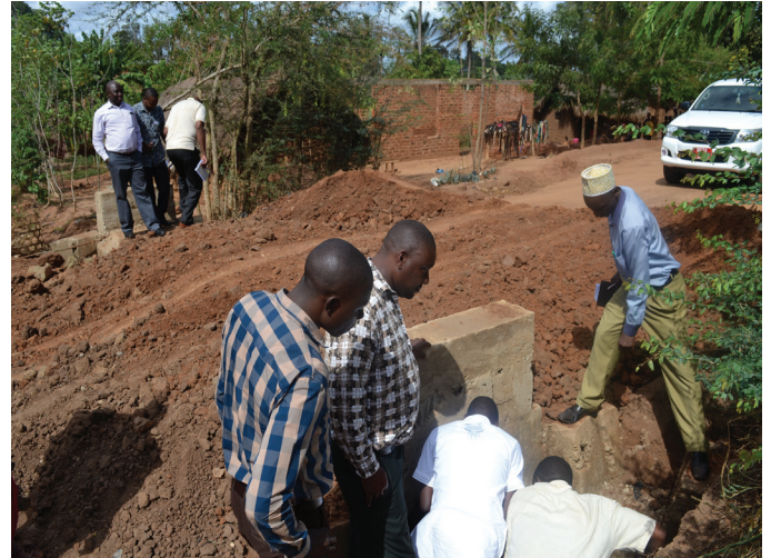
Kamati ya Fedha, Uchumi na Mipango ikiendelea na ukaguzi wa ujenzi wa barabara ya komkonga-luiye-mzungu katika kuangalia kiwango na ubora wa barabara hiyo.
