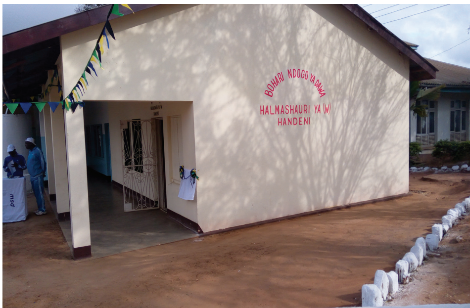
Jengo la bohari ndogo ya kuhifadhiwa dawa Halmashauri ya Wilaya ya Handeni.
