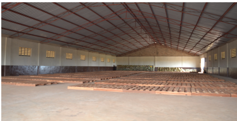
Muonekano wa Ndani wa Ghala la kuhifadhia Nafaka lililojengwa Kata ya Kwachaga Halmashauri ya Wilaya ya Handeni.
