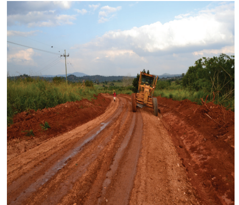
Ujenzi wa Barabara ya Kwamkono -Kweditilibe yenye lengo la kuimarisha usafirishaji na kuboresha huduma za usafiri.
